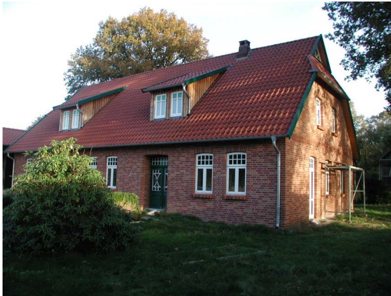
Dächer und Fassaden
